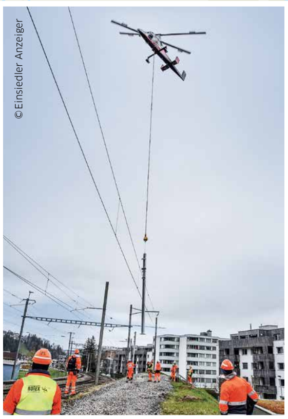
Rund 70 Fahrleitungsmasten müssen beim Bahnhof Einsiedeln neu gesetzt werden.
